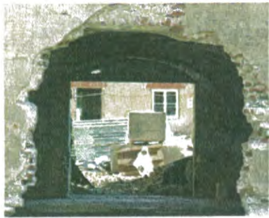
Sehr ungewöhnliche Durchblicke bietet das Meringer Schloss, solange noch so grundlegend an der Struktur gearbeitet werden muss.
